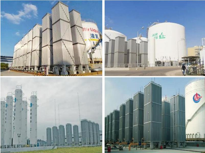
O vaporizador é um equipamento de troca de calor de alta eficiência e economia de energia que utiliza a convecção natural do ar para aquecer o líquido criogênico no tubo de troca de calor para evaporá-lo completamente em gás.
