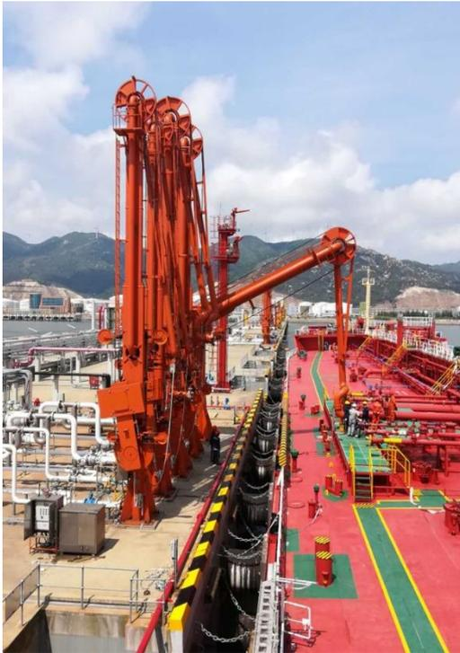
Utilizados para carregar ou descarregar navios ou embarcações que transportam líquidos ou gases. Todo o sistema inclui principalmente Braços de Carregamento Marítimo, Unidade de Potência Hidráulica, Painel de Controle, Tubos Hidráulicos e Cabos Elétricos, entre outros.
